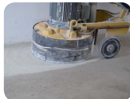
Úprava povrchu brúsením
